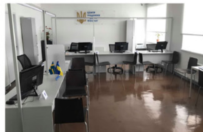
Наливна підлога кольору RAL 8025 у основному приміщенні фронт-офісу
