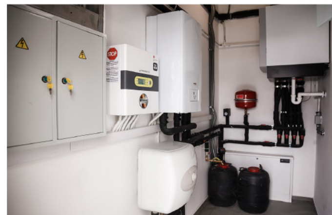
Система теплового насосу "повітря/вода"
