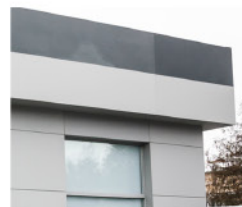
Для фасаду ЦНАП в Миколаївській громаді використано фіброцементні плити
